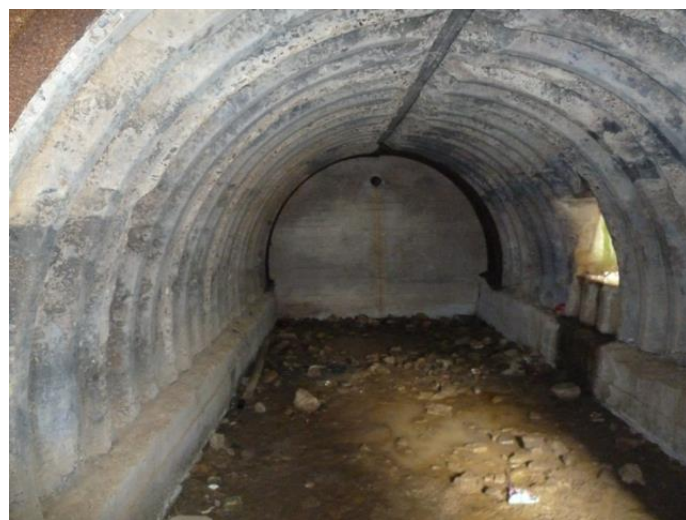
Abri troupe du type SK pour 12 soldats. L'une des deux salles. A droite la sortie de secours réglementaire.
