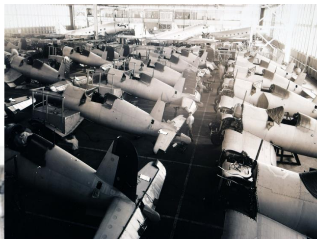
Remise en état de chasseurs Chance Vought F4U en 1950 à Jacksonville Floride.
