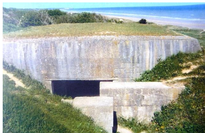
Murs en chicane à l'arrière des casemates.
