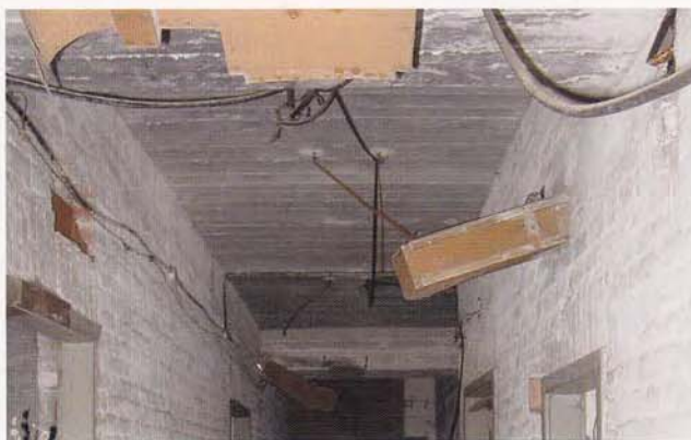
Leitturm Arenbergpark, zerstörte Lüftungskanäle aus Hartfaserplatten
