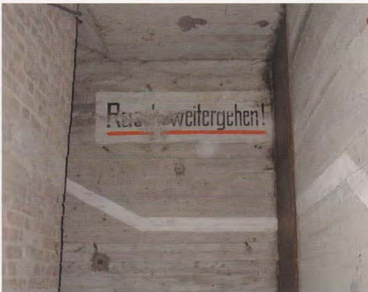
„Rasch weitergehen!“ Aufschrift im Stiegenhaus und eine weiße Leitlinie, die bei Lichtausfall fluoreszierte
