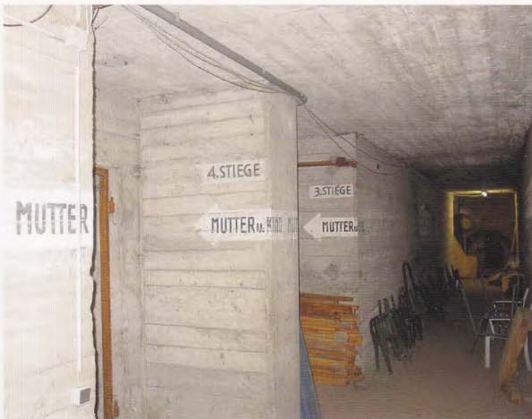
Leitturm Arenberpark; erhaltene Orientierungsaufschriften für den Zivilen Luftschutz
